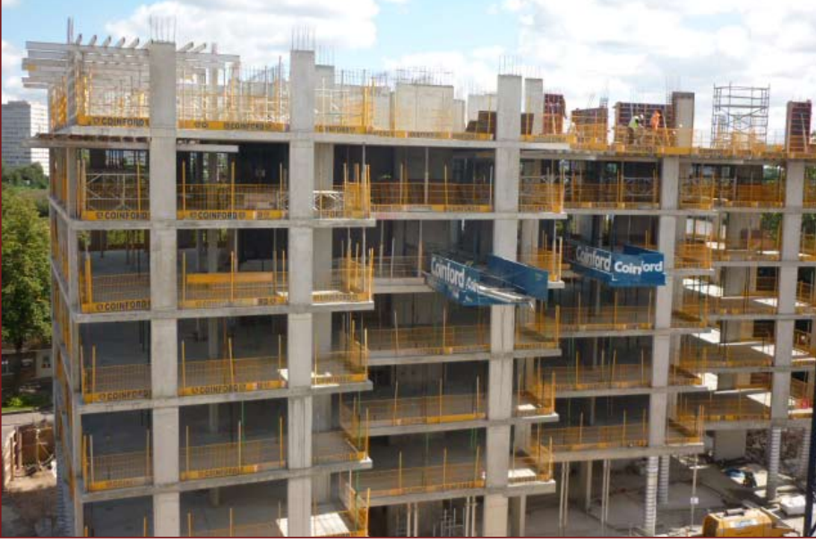
Eski Okul Arazisinde inşaat halinde olan konutlar
