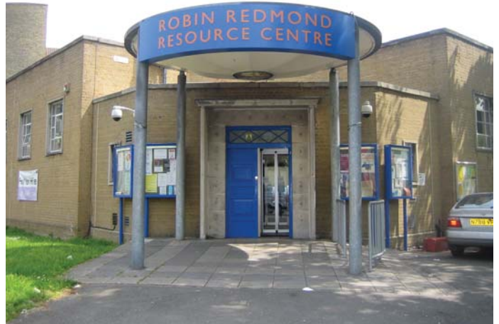
Ek paralar kütüphane, Robin Redmond Resource Centre ve CCTV için harcanacak
