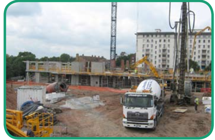
Ağustos 09 Blok F 1. Kat seviyesine çıktı
